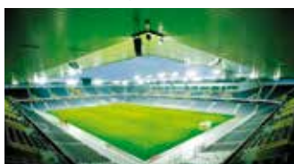
MONTAWALL® Stade de Suisse, Berna (CH)
