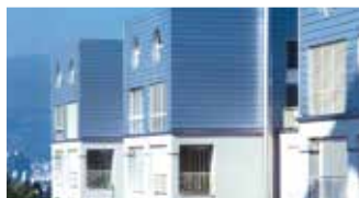
MONTAFORM® Wohnsiedlung, Olten (CH)
