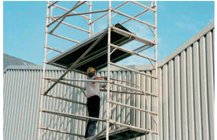
Pintura de recubrimiento del revestimiento de una fachada.
