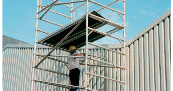
Перекраска стеновой панели.
