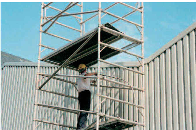
Ponowne malowanie pokryć ścian.
